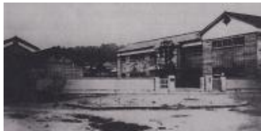
昭和24年完成の新校舎
